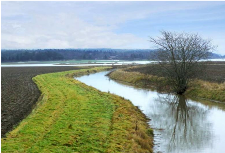
Figur 4. Vanlig skyddszon på vänster sida och avsaknad av skyddszon på höger sida. (Foto Monica Kling).
